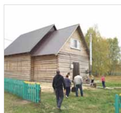
Podjelskin komikirkon rakennusvaiheita. Kirkon rakentamiseen osallistuivat niin pienet kuin isotkin.
